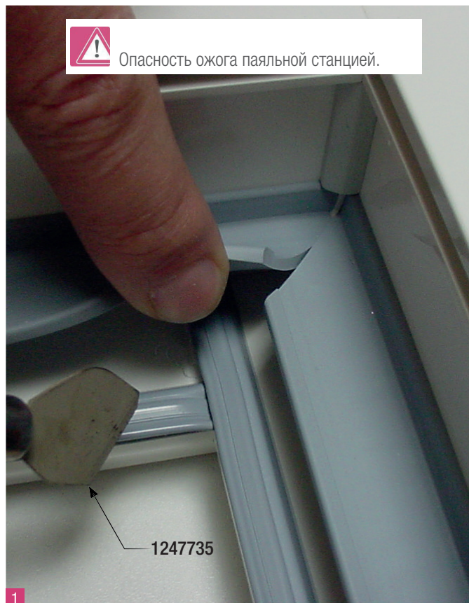
Раскрывается сварной шов центрального уплотнения.
