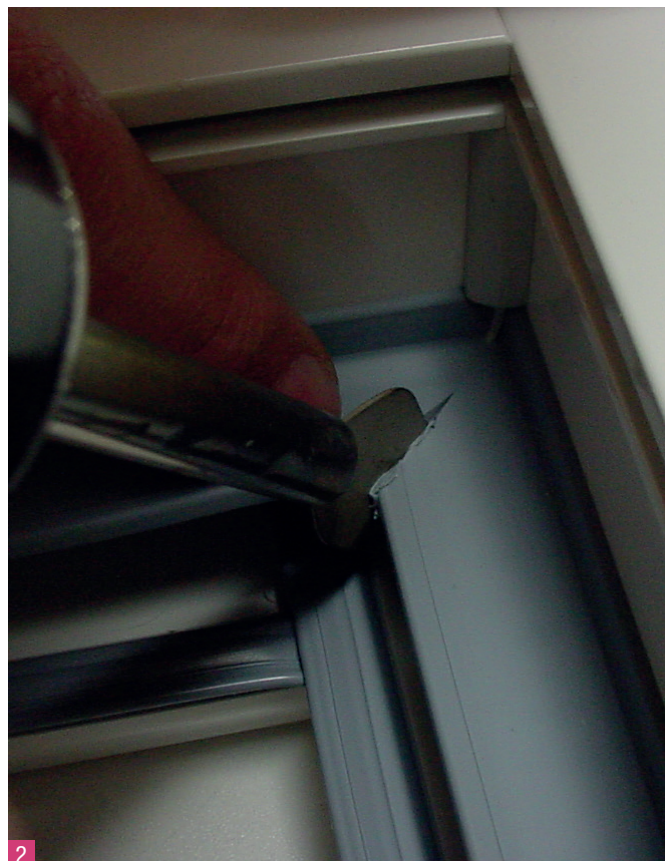
Передняя часть уплотнений расплавляется при температуре ок. 250-270 °С в течение 3 сек.
